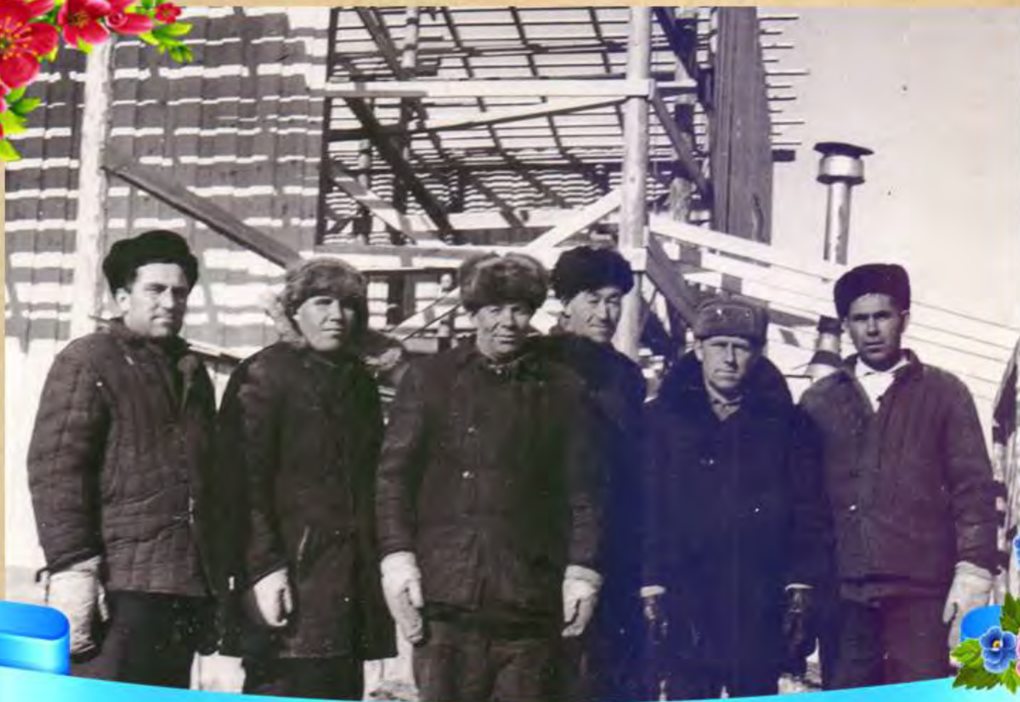
Строительная бригада совхоза «Шергинский» на строительстве сушилки
